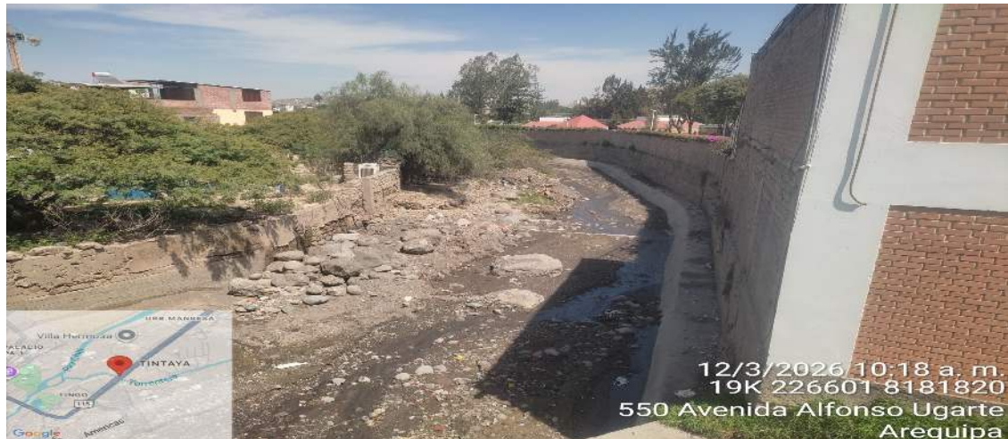
IMAGEN 01: SE OBSERVA LA COLMATACION Y EROSION EN LA MARGEN IZQUIERDA DE LA QUEBRADA QUE REQUIERE DE MURO DE CONTENCIÓN EN LA MARGEN DERECHA ECISTE UN MURO DE CONCRETO SEGUIDO DE UN MURO PORTANTE DEL COLEGIO PRESCOTT
